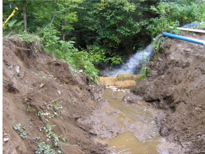
**Figure 3** : Mesures de contrôle de l'érosion lors de la période des travaux.
